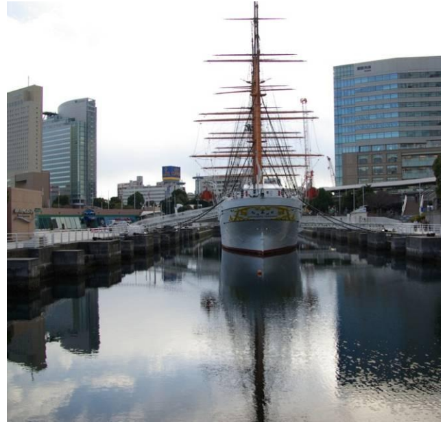
図4 旧一号ドック 活用事例
