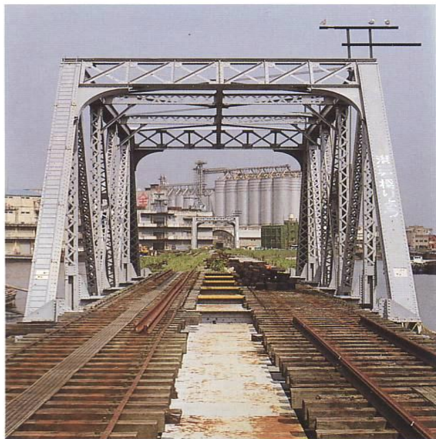
図6 港橋梁 『横浜の土木遺産』から引用
