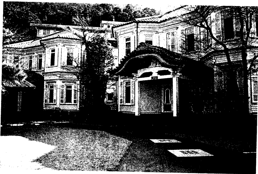
箱根富士屋ホテル1号館(右) 2号館(左) 1906(明治39)年竣工
